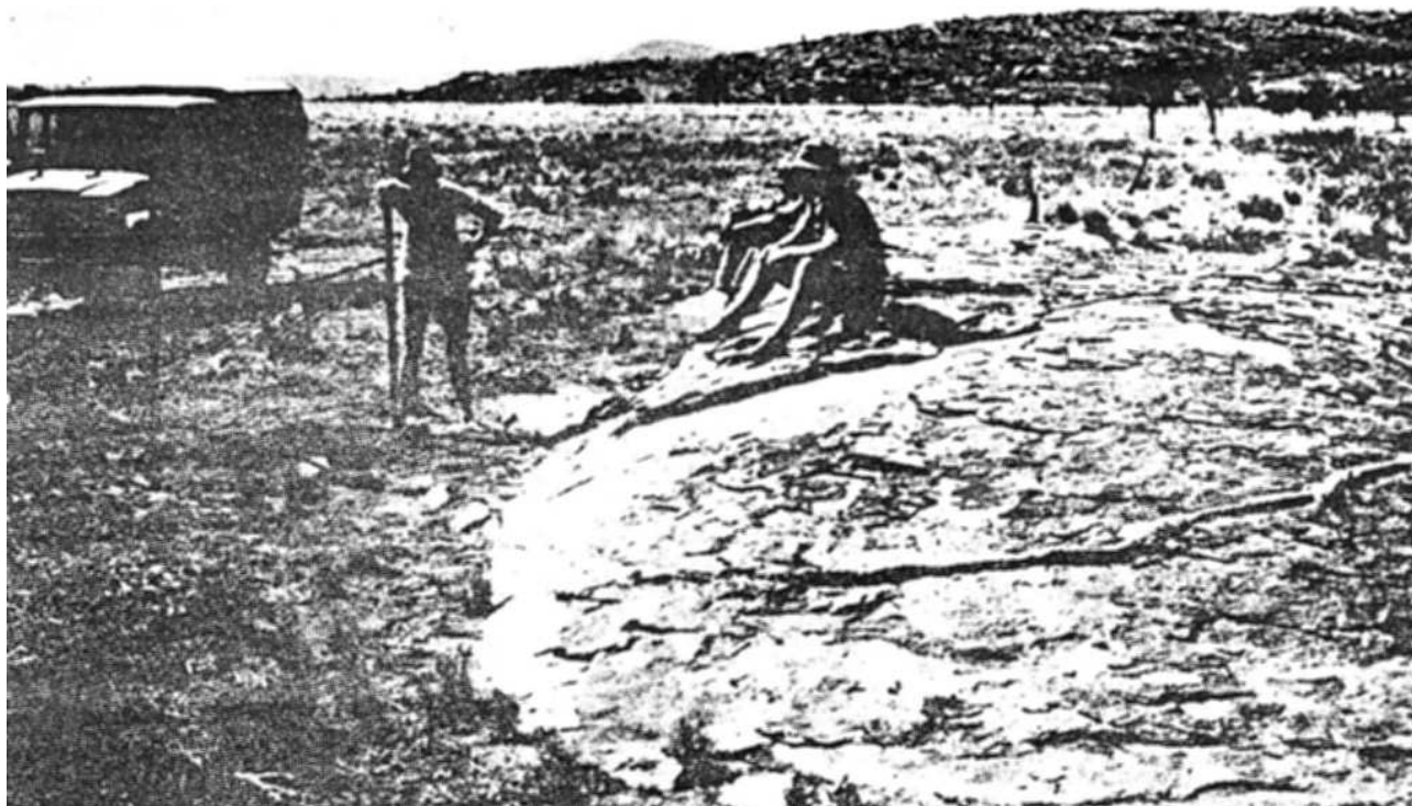
PHOTO 5.7 : WOMNIKUTTR — UN PETIT DÔME MUNI D'UNE GOUTTIÈRE EN CIMENT PAR ANDREW ET KIM MÈNE A UN ENCLOS PLANTÉ DE PISTACHIERS (VOIR FIG. 5.5). LA GOUTTIÈRE RESSEMBLE R UN SERPENT SUR LE ROCHER.
