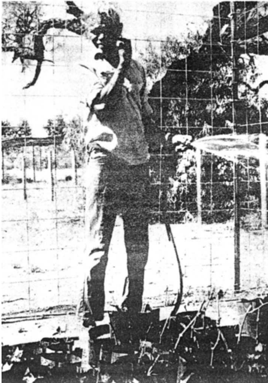
PHOTO 5.1 : KIM TIJAYA DANS LA NOUVELLE PÉPINIÈRE D'ERNABELLA. LES MURS SONT FORMÉS DE GRILLAGE. ON RECOUVRE POUR FAIRE DE L'OMBRE ET ON SUSPEND DES ARROSEURS AU PLAFOND. DE TELLES PÉPINIÈRES PEUVENT ÊTRE ÉRIGÉES PARTOUT.
