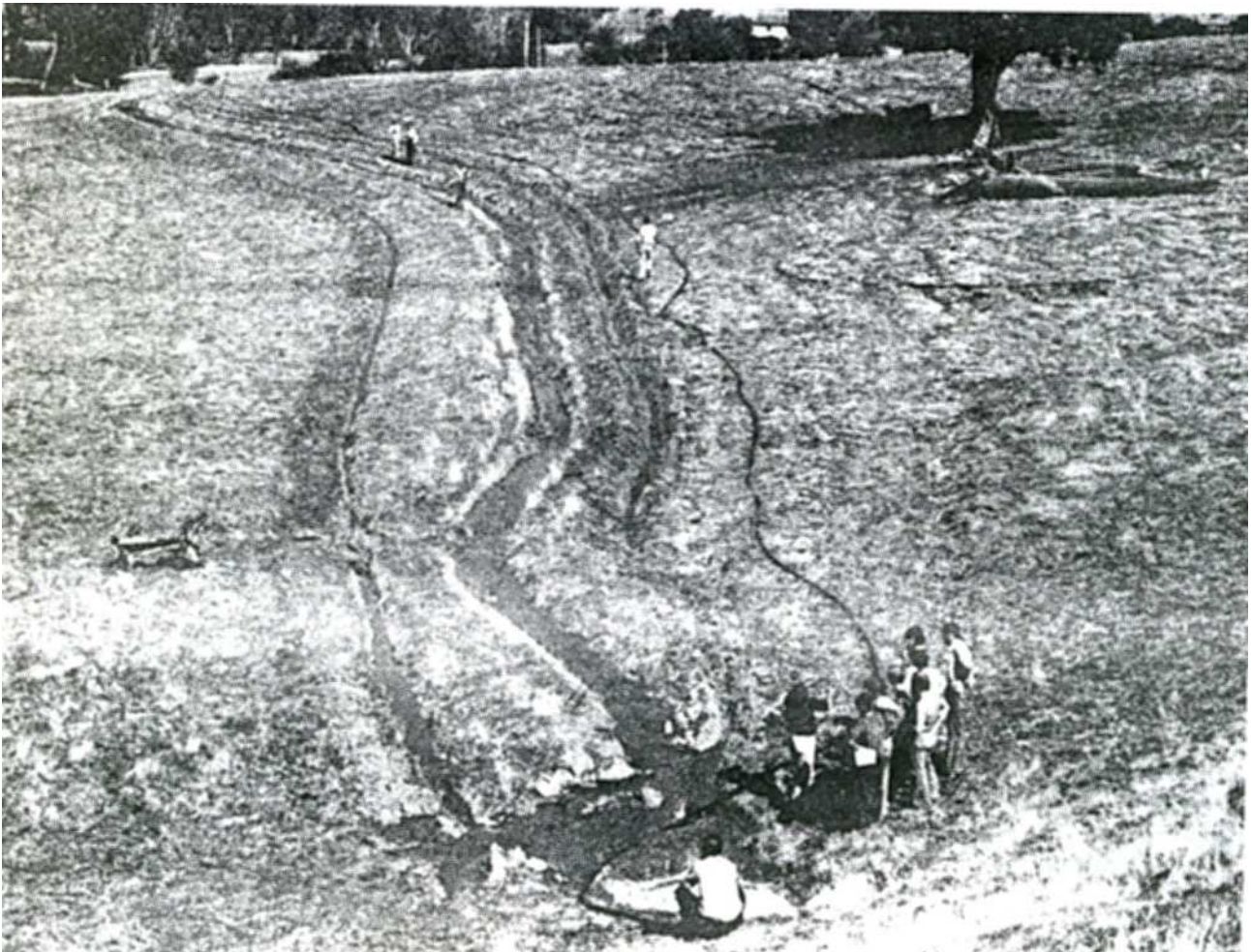
PHOTO 7.4 : VUE DU HAUT DU MUR DU BARRAGE DE LA PHOTO 7.3. LA VANNE EST OUVERTE POUR INONDER LE CANAL D'IRRIGATION.
